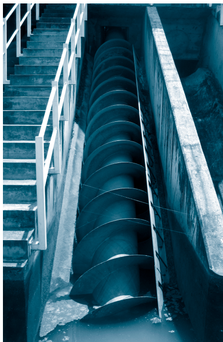
Turbine de la station d'épuration.
