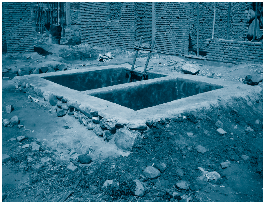
Deuxième puits d'épuration, voisin du premier: l'eau est filtrée par un système de pierres.
