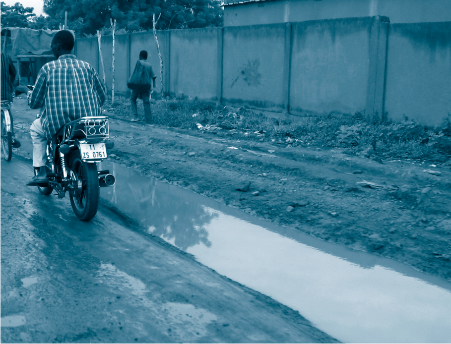
Manque de caniveaux d'évacuation des eaux à Ouagadougou.
