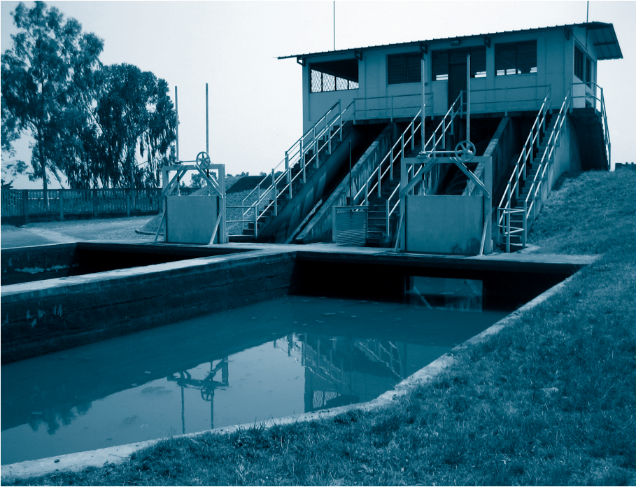
Station d'épuration de Bujumbura.
