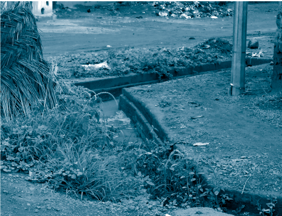
Caniveaux d'évacuation à Ouagadougou.
