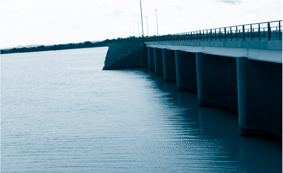
Le barrage de Ziga.
